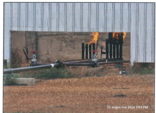
ภาพที่ 2-1 ปล่องเผาก๊าซแนวนอน (Horizontal Flare) คั่นคอนกรีตและกำแพงกันแสง
