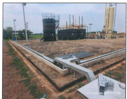
ภาพที่ 2-13 การติดตั้งอุปกรณ์การผลิตบนพื้นคอนกรีตที่มีรางระบายน้ำล้อมรอบ
