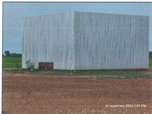
ภาพที่ 2-1 ปล่องเผาก๊าซแนวนอน (Horizontal Flare) คั่นคอนกรีตและกำแพงกันแสง
